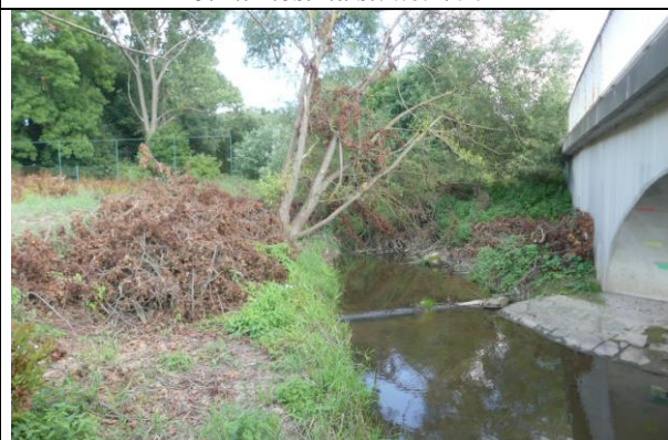
Tok nad jižním mostem, příčný práh z kulatiny a vzdutí
